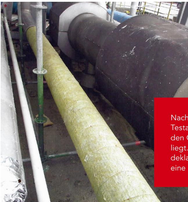
Nach drei Jahren Einsatz erzielte der ProRox® WR-Tech Testabschnitt  $0,1 \text{ kg/m}^2$  Wasseraufnahme, was weit unter den Grenzen der europäischen Norm EN 13472 ( $<1 \text{ kg/m}^2$ ) liegt. Dieser Wert liegt unterhalb des von ROCKWOOL deklarierten Wertes von  $0,2 \text{ kg/m}^2$ , der standardmäßig eine Sicherheitsmarge beinhaltet.
